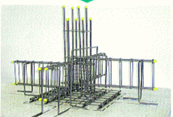
⑫ ベース・柱・梁のかぶり、ピッチ、結束等と全体のねじれ、倒れを確認、調整する。
