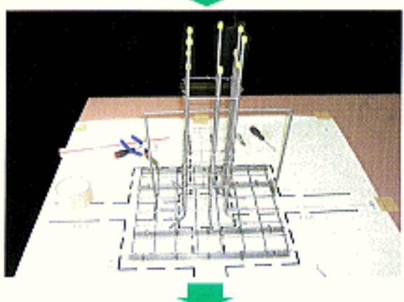
④ 柱筋にピッチ割りし、うまを設置する。
